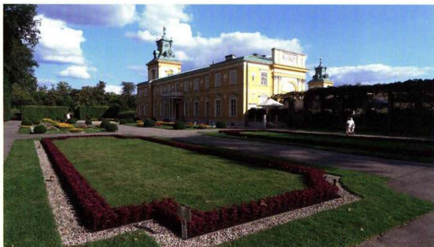
Slottet i Wilanow. Foto: Sten Ridderlöf.
