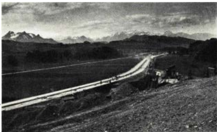
En nyanlagd sträcka av Reichsautobanan München—Salzburg. Schaktningsarbeten och plantering av området närmast banan ännu icke slutförda.
