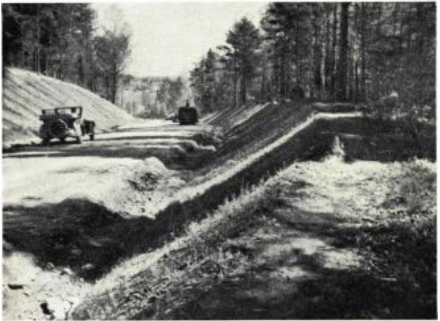
Den »tekniska slänten» — exakt och omsorgsfullt utförd — men ack så främmande i miljön.
