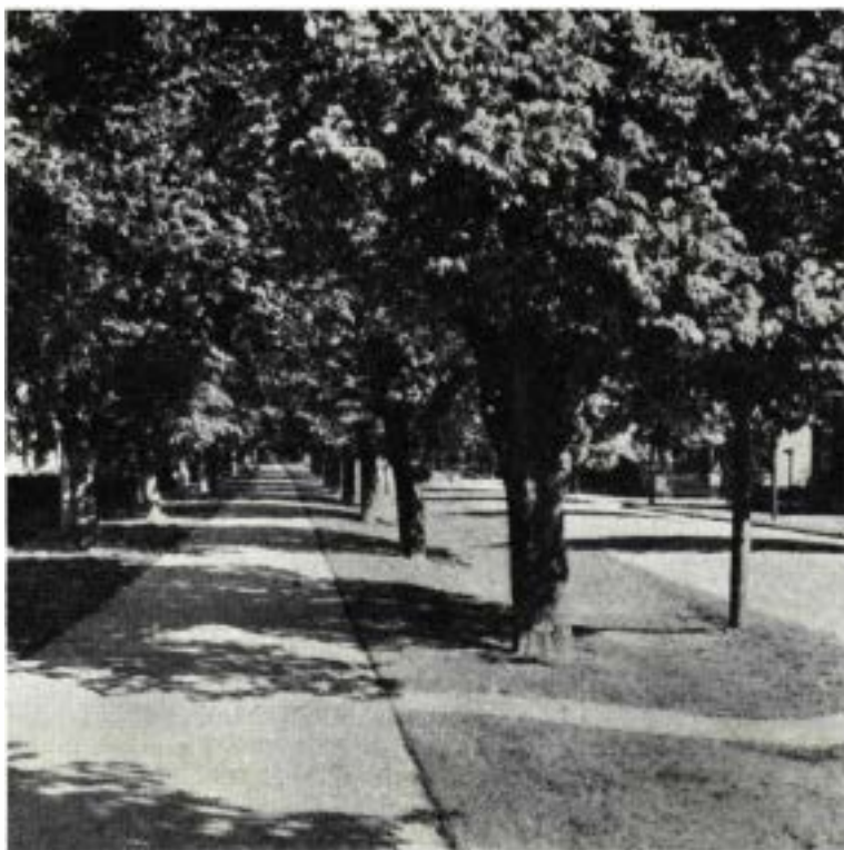
Den gamla vägen har blivit gång- och cykelbana, den nya ligger vid sidan av allén. Mellan körbanan och gångbanan har lagts en skålformad gräslinda, som ersätter diket. Ålsten, Stockholm.
