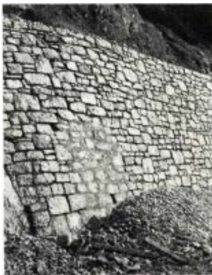
Nylagd stödjemur. Stenarna är tillhuggna för hand. På sina ställen är denna mur ända till c:a 6 m hög.
