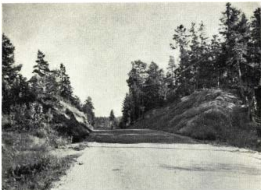
Förnämligt utförd sprängning som icke lämnar något övrigt att önska. Skrevorna ha fyllts med jord och avtäckts med grästorv. Bild från Västerhaninge, Södermanland.
