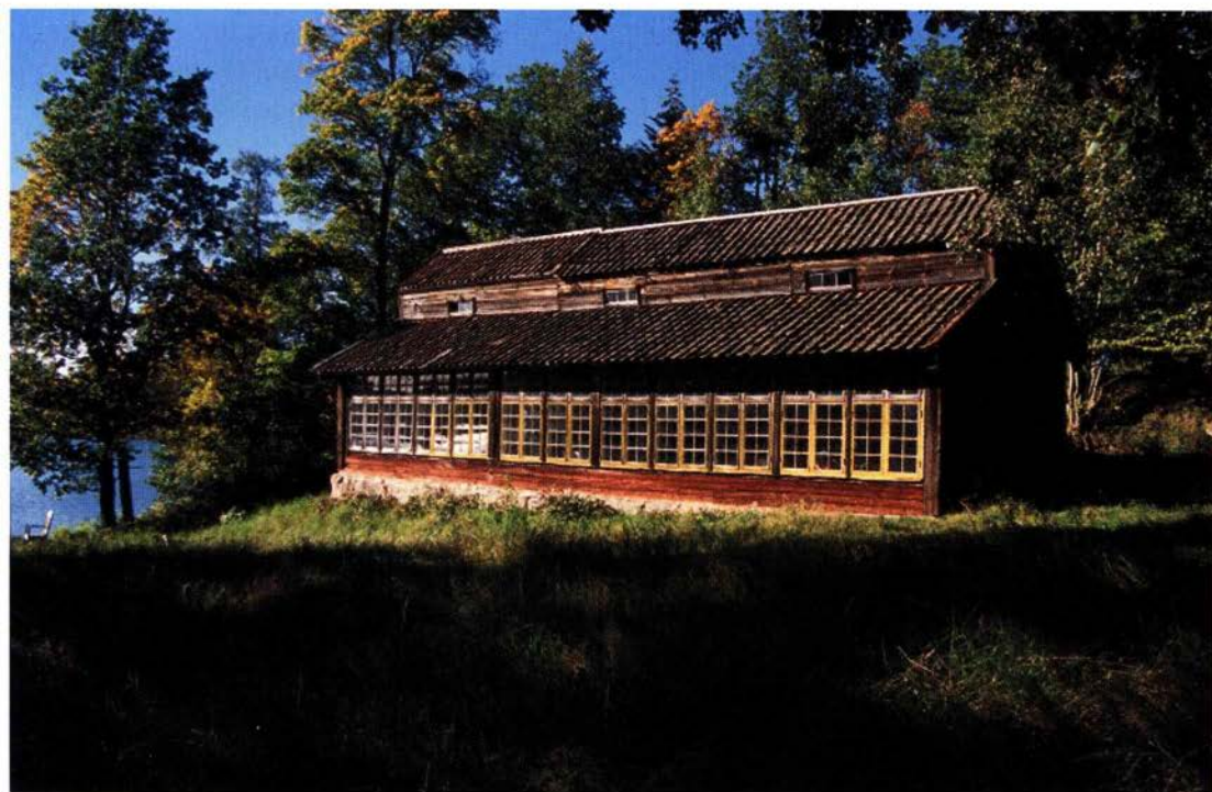
Orangeriet vid Regnaholm i Östergötland är troligen uppfört någon gång före 1828. Det har en för det tidiga 1800-talet typisk form. Den södra fasadens fönster är numera utbytta och det nedre takfallet hade ursprungligen ett glasat tak.
