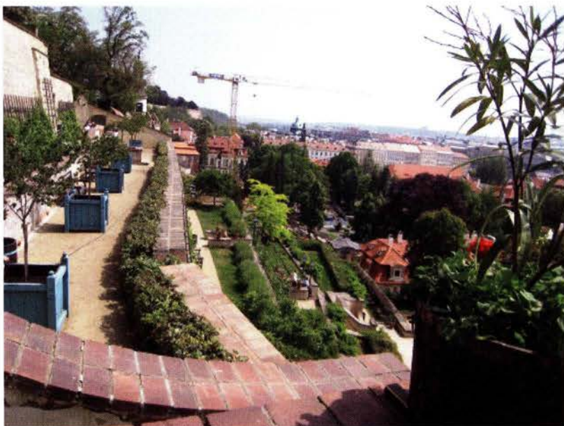
Terrassanläggningen från väster.
