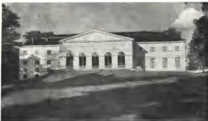
Fig. 97. Drottningholm. Teaterhusets västra fasad efter ombyggnaden 1791. La façade occidentale du théâtre après les travaux de reconstruction 1791.
