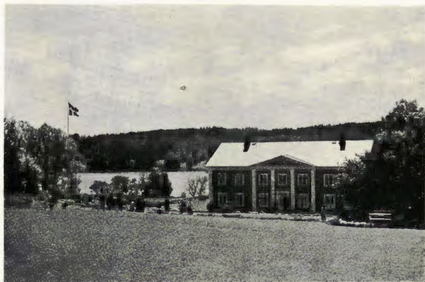
Fig. 4. Skåpafors från landsidan. Foto: H. WIKSTRÖM 18 juni 1938.
