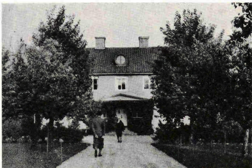
Överingenjörens trädgård. — Trädraderna trängde långt fram mot byggnaden och lämnade endast plats en blick rakt ut i allén.
