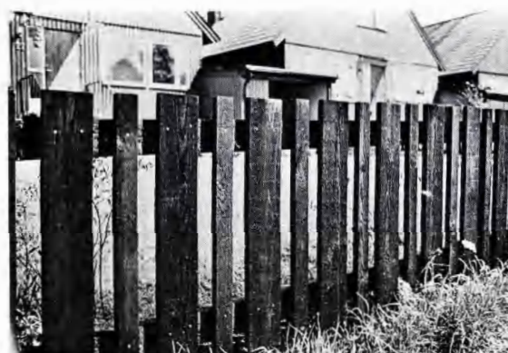
Fig. 2. Villastaket impregnerat enligt den s. k. Royalprocessen (= Hagerprocessen). Denna ger en produkt, som är tryckimpregnerad och infärgad. Ett flertal färger finns och färgbeständigheten är enligt provningar mycket god. (Foto: AB Statens Skogsindustrier.)
