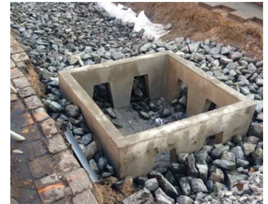
Anläggning av skelettjord. I betongfundamentet planteras trädet i det växtsubstrat som beställaren förordar. Stenskriv utgör bilden "skelettet" och i utrymmet mellan kan trädrotter leta sig vidare utan att löpa risk för kompakteringsskador.
