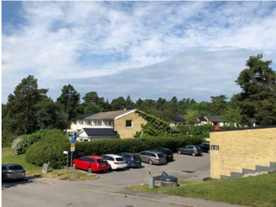
Nämndemansbackens radhusområde från tidigt 1960-tal ligger på en tallskogklädd kulle i Skarpnäck. Området gränsar till riksintresset Skogskyrkogården i fonden i bilden, samt till riksintresset Pungpinans egnahemsområde.
