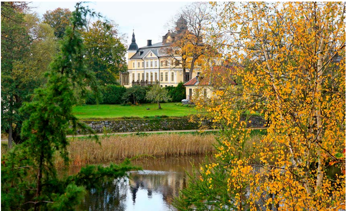
Slottets sydöstra fasad mot slottsparken.
