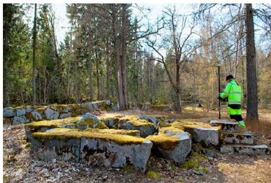
Grunden till Belvederen mäts in av Inga Blennå. Grunden är kallmurad med tre trappsteg mot norr. I bakgrunden syns muren som omger parken och trädgårdarna. Foto: Karin Lindeblad, Arkeologerna.
