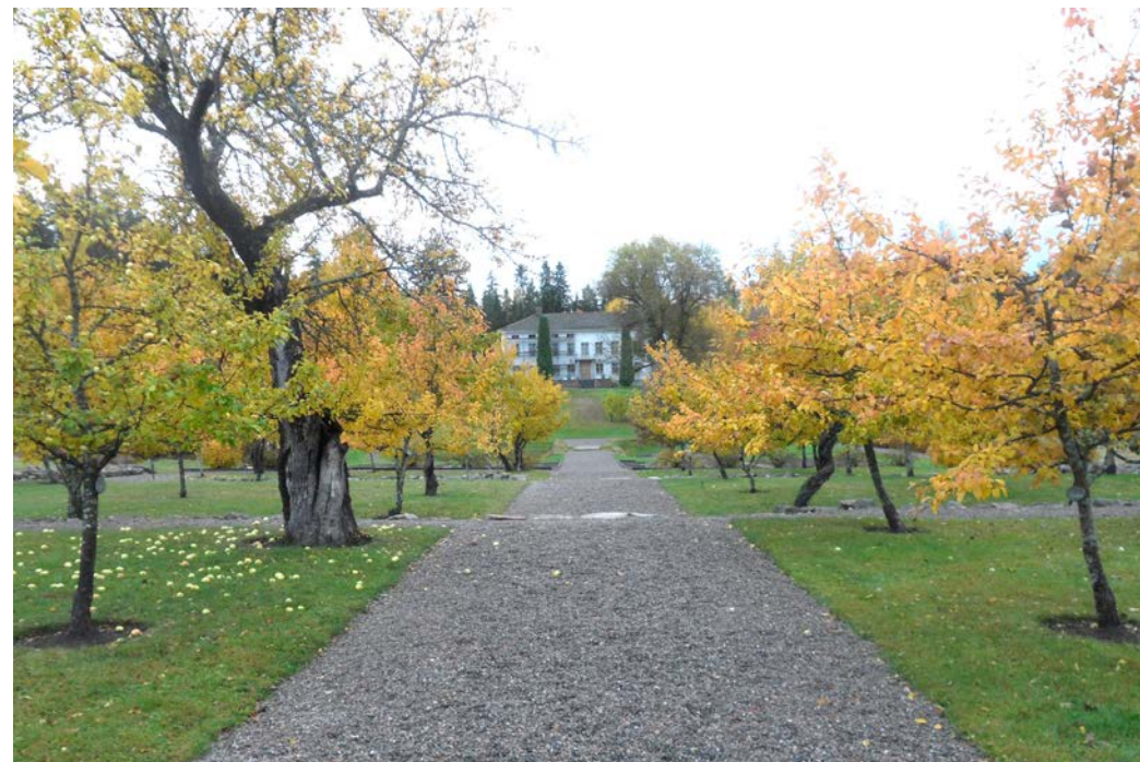
Utsikt från Gamla Staberg mot Nya Staberg 2016. Till vänster om mittgången står det gamla Boikenträdet. På Nya Staberg pågår arbete med att återskapa småfönstren under takfoten.
