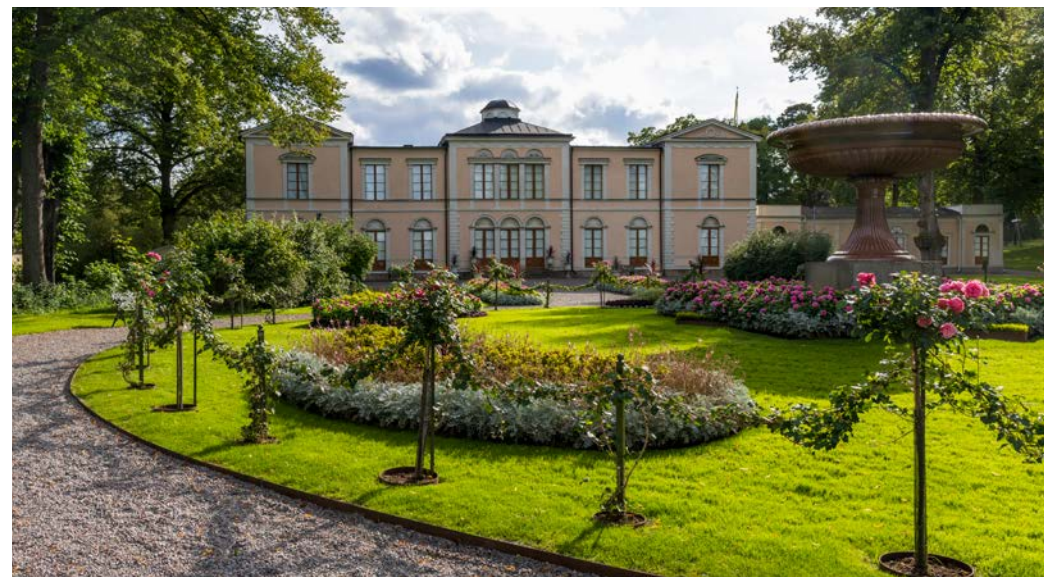
Rosendal, de återskapade planteringarna runt porfyrunan på slottsterrassen. Foto: Nivå landskapsarkitektur.
